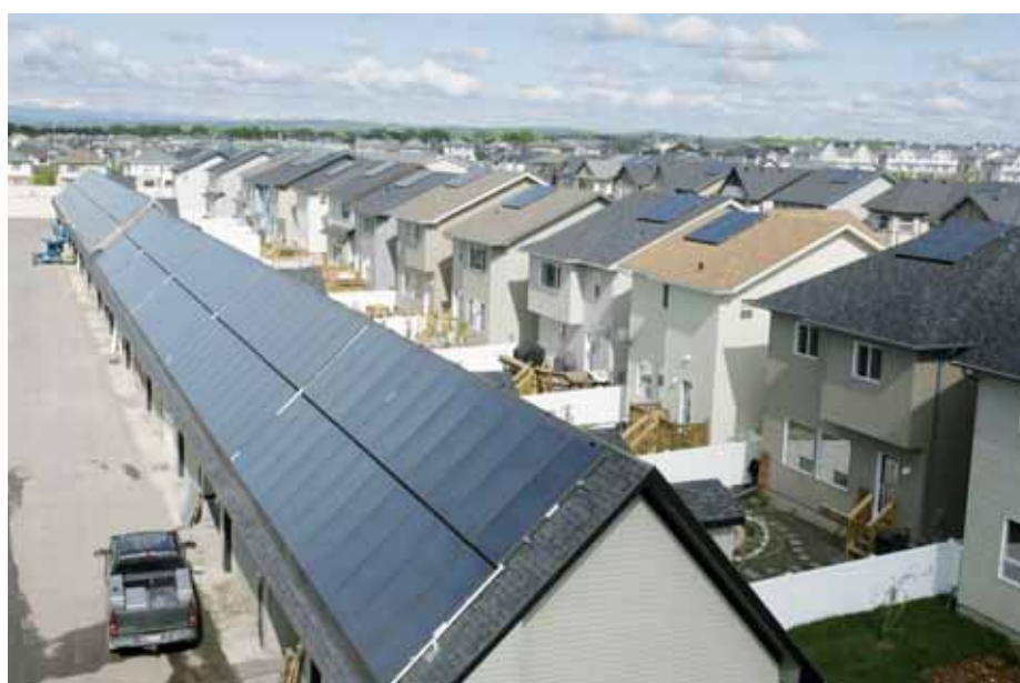
Drake Landing Solar Community (Alberta, Canada), un gruppo di 52 abitazioni da 130-150 mq ciascuna, è stato dotato di ottocento mq di collettori e di un sistema di stoccaggio sotterraneo del calore che assicura loro il 90% del fabbisogno di acqua calda sanitaria e di energia termica per il riscaldamento invernale.
